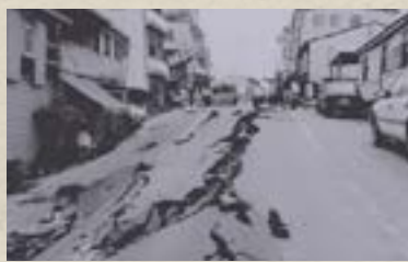
強震造成石岡村地面嚴重隆起，道路發生大規模龜裂
